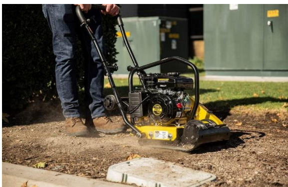
Figuur 54: Een trilplaat verdicht het zand.
